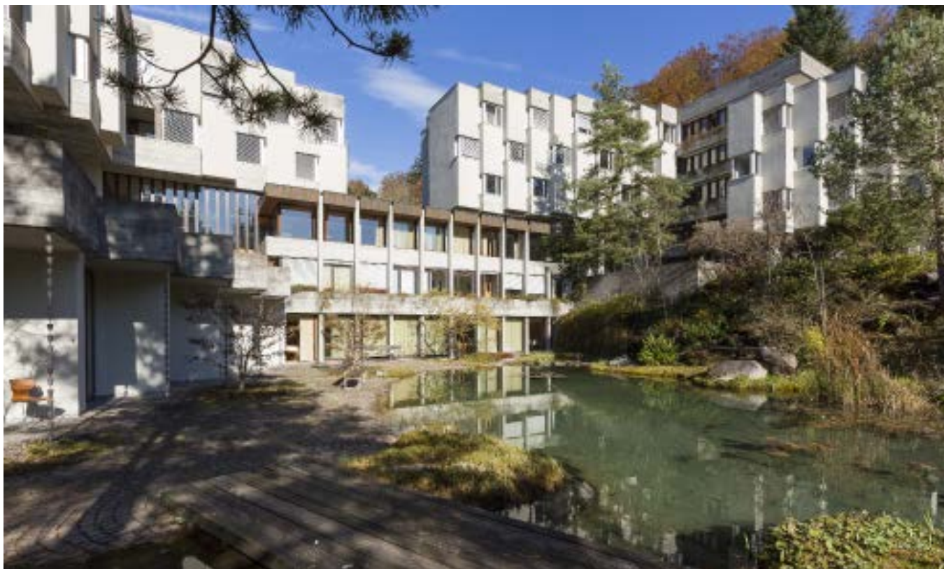
Ein Grossprojekt: Nach der umfangreichen Renovation ist das Lassalle-Haus Bad Schönbrunn für die Zukunft gut gerüstet.
